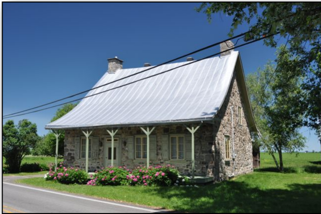
MAISON ARCHAMBAULT HOUSE 1520, rang de la Rivière Nord
