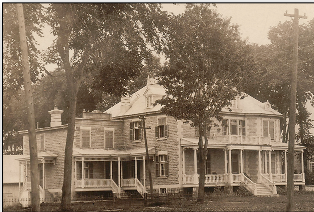
PRESBYTÈRE – RECTORY 1188, rue Principale
