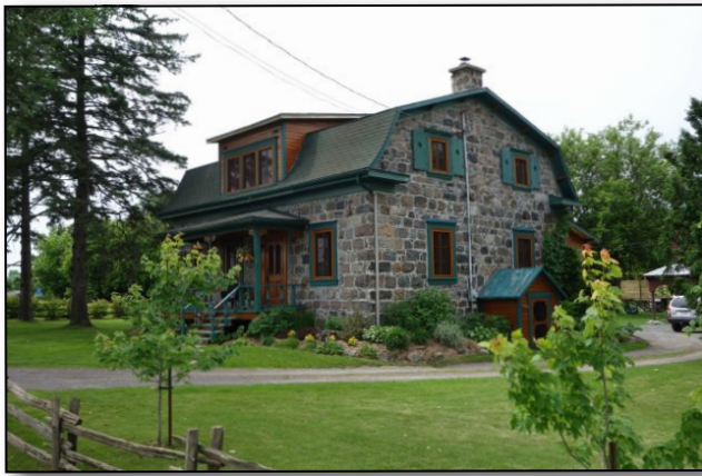
MAISON ALLARD-LABRÈCHE HOUSE 528, rang du Ruisseau-des-Anges Sud
