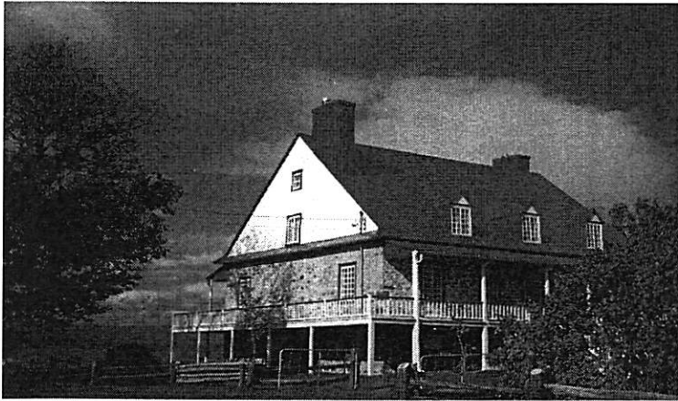
Presbytère de Berthier-sur-Mer construit au début du 18e siècle
